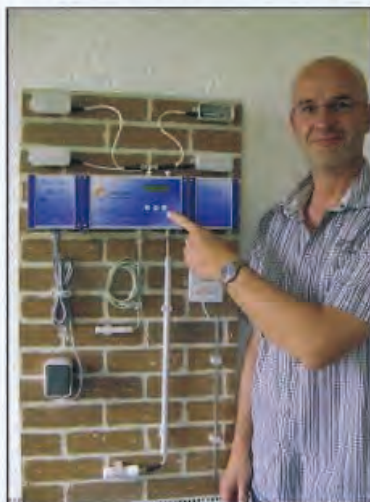
Immense Bauarbeiten sind unnötig, um Gebäude vom Keller aufwärts trocken zu bekommen. Diese Matrolan-Anlage ist die patentierte, kreative Lösung, die Günter Groß stattdessen installiert.
