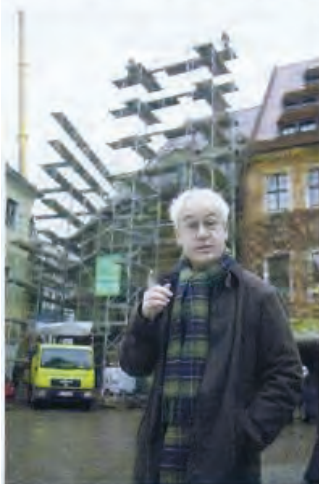
Feuchte Mauern - Bauherr und Schauspieler Tom Pauls saniert ein spätgotisches Pirnaer Bürgerhaus.
